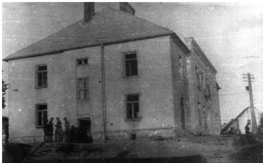
Budynek posterunku MO w Zakrzówku po ataku w nocy z 22 na 23 VI 1945 r. Na zdjęciach widać powybijane szyby i dziury po kulach. Fot. AIPN
