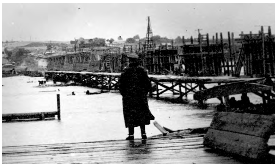
Widok na budowę niemieckiego mostu przez Wisłę w Annopolu (1940 r.). Fot. Zbiory prywatne Dariusza Zgardzińskiego
