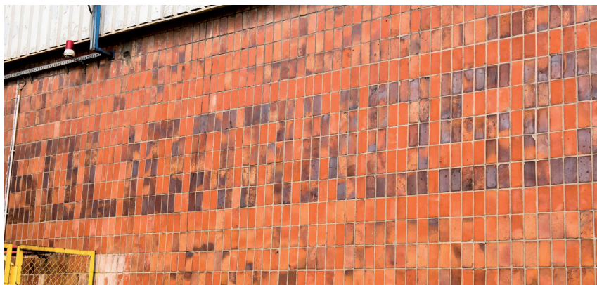
Fot. 16. Napis „Solidarność” wymurowany na elewacji jednego z budynków Elektrowni „Połaniec”. Zbiory Elektrowni w Połaniecu
