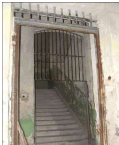
Kraty w drzwiach prowadzących do skrzydła wschodniego więzienia kieleckiego (stan obecny).
